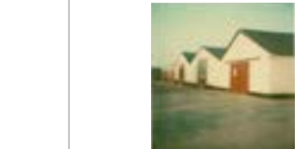
Bouw nieuwe werkplaats in Achthmaal
