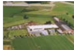
Erweiterung der Produktionshallen in Achtmaal
