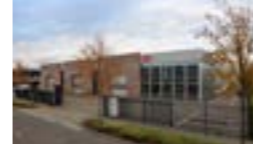
La nouvelle usine pour la production Tulip est mise en service
