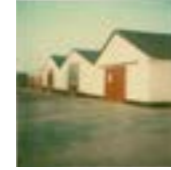
La construction de la nouvelle usine à Achtmaal
