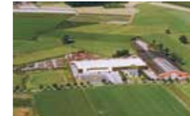
Uitbreiding fabrieksruimte Achtmaal
